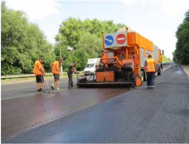
Рис. 3. Ремонт дороги Н-03 Житомир –Чернівці за технологією «Сларрі-Сіл»
